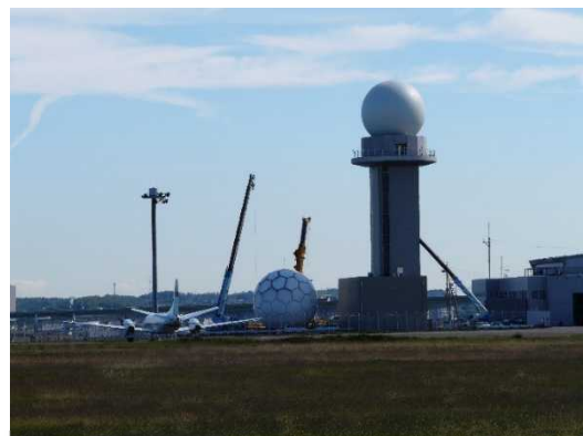
第1図 令和元年の二重偏波空港気象ドップラーレーダーへの更新工事の写真 旧レドームが取り外され、新しいレドームが取り付けられています。
