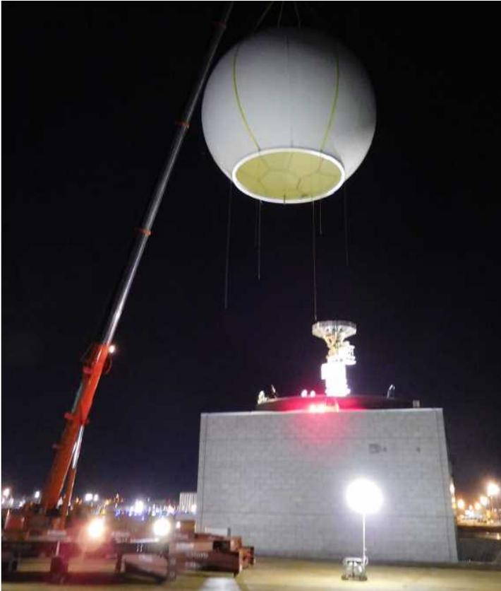
第7図 クレーンによるレドーム吊り上げの様子
