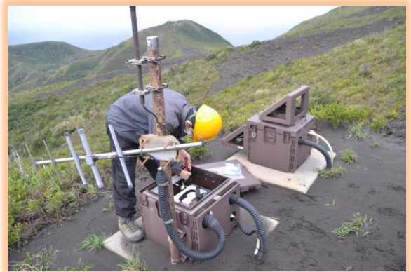
諏訪之瀬島(鹿児島県)の修理対応の様子
