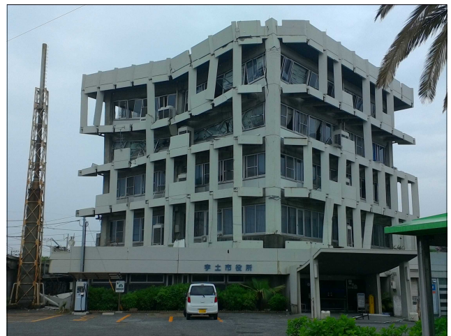
平成28年（2016年）熊本地震で被害を受けた宇土市役所 （熊本県宇土市）
