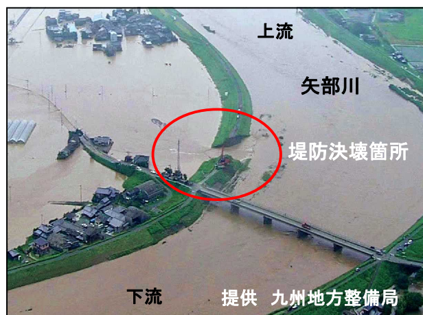
平成24年（2012年）7月九州北部豪雨で発生した被害 河川の堤防決壊（福岡県柳川市）
