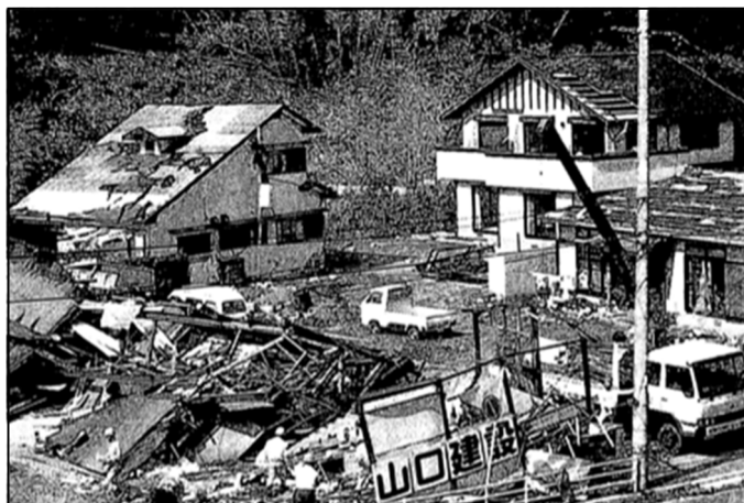
屋根が飛ばされた家屋
