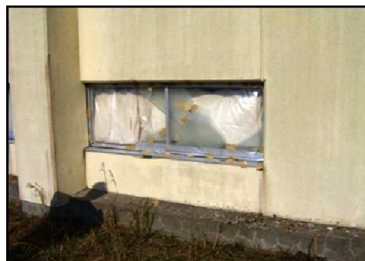
平成23年(2011年)2月2日 霧島市牧園町で空振により破損したガラス
