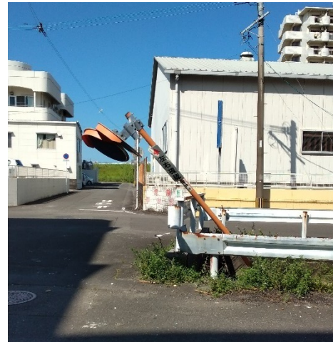
② カーブミラーの支柱の傾倒
