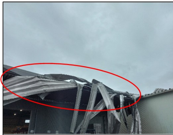
③ 付近の工場から飛散した屋根ふき材
