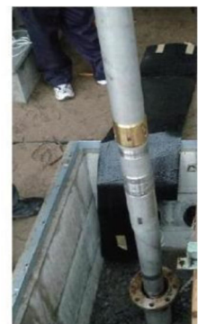
観測孔に埋設される 傾斜計センサー
