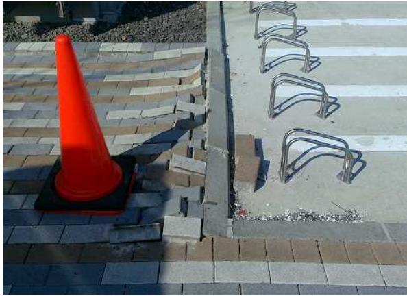
写真3：歩道インターロッキングのずれ（地盤沈下）（福島県国見町）
