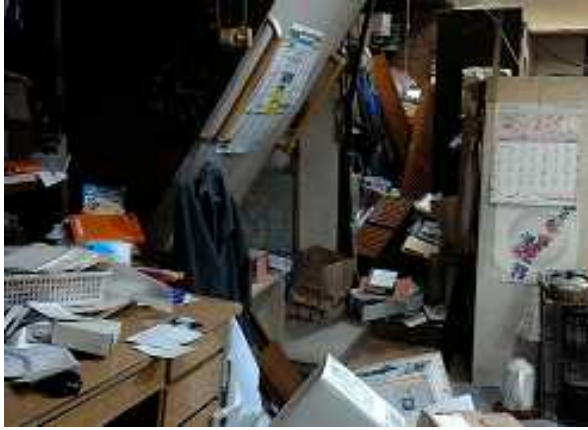
写真7：民家室内の状況（福島県相馬市）
