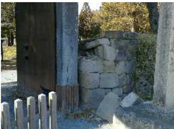
写真5：神社の石垣の崩れ（福島県相馬市）
