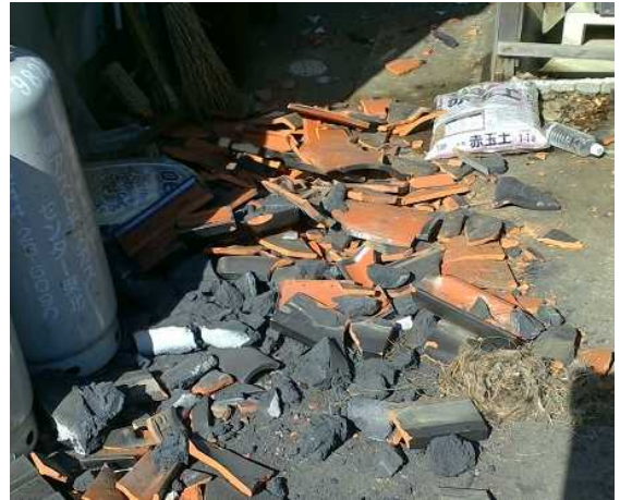
写真10：民家の屋根瓦の破損（落下）（福島県新地町）
