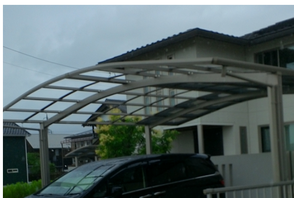
⑤ 飛散したカーポートの屋根パネル (南東方向から撮影)
