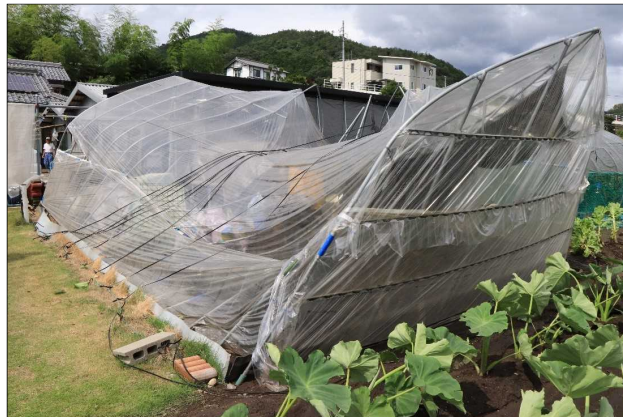
② 鋼管が変形したパイプハウス (南方向から撮影：八百津町提供)
