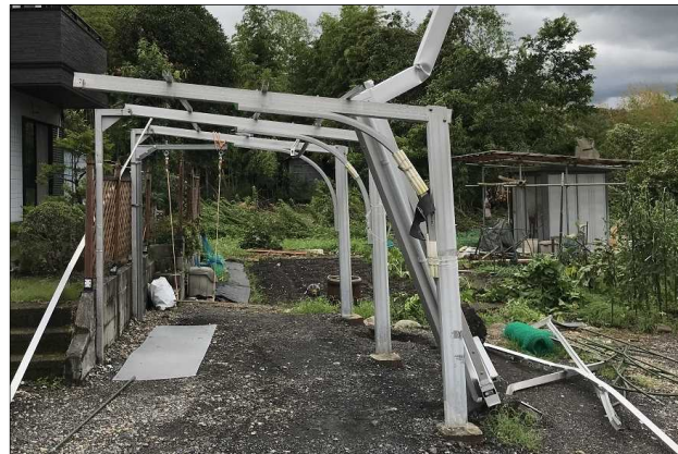
④ 屋根部分が飛散したカーポート (西方向から撮影：八百津町提供)
