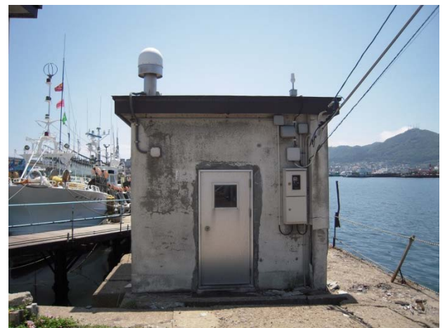
図2 津波観測施設（函館）
