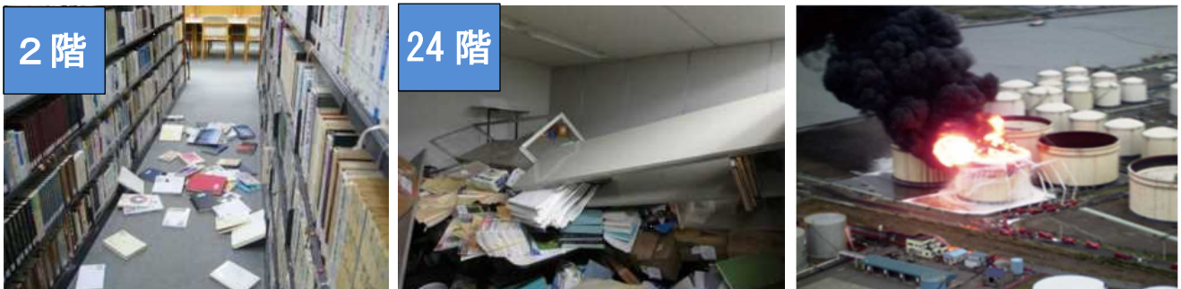
図2 （左・中）東京都内の同じビル内での被害の違い（工学院大学提供） （右）苫小牧の石油タンクの被害（総務省消防庁 消防研究センター提供）
