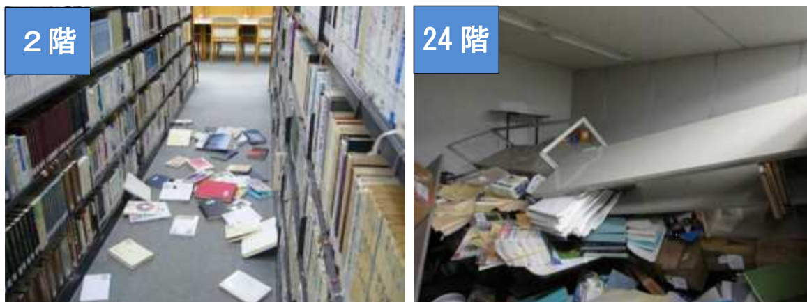
図2 東京都内の同じビル内での被害の違い（工学院大学提供）
