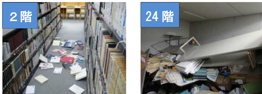
図2 同じビルの高階層と低階層での被害の違い（工学院大学提供）
