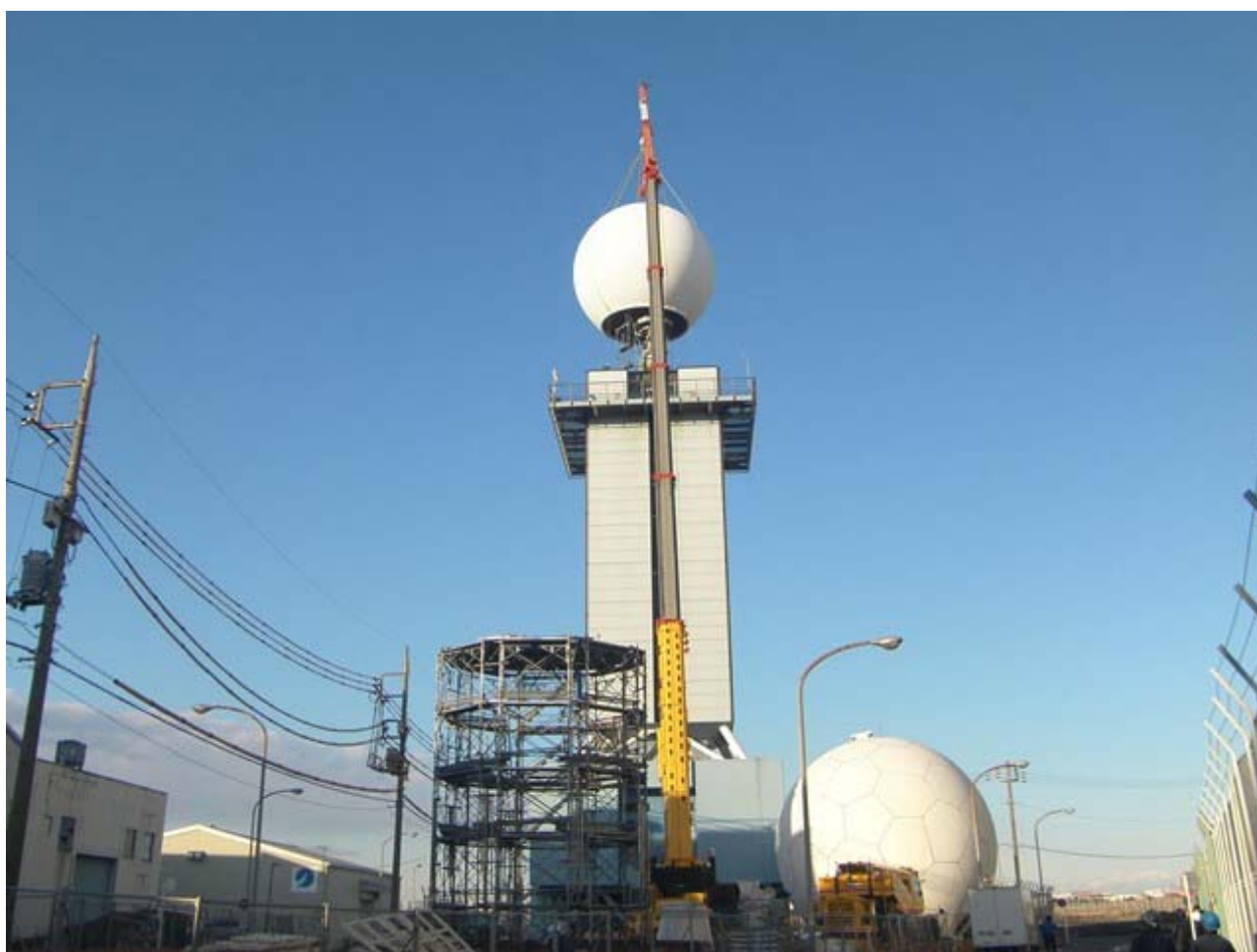
2016 年 2 月 2 日 大型クレーンを用いた新レドームの設置
