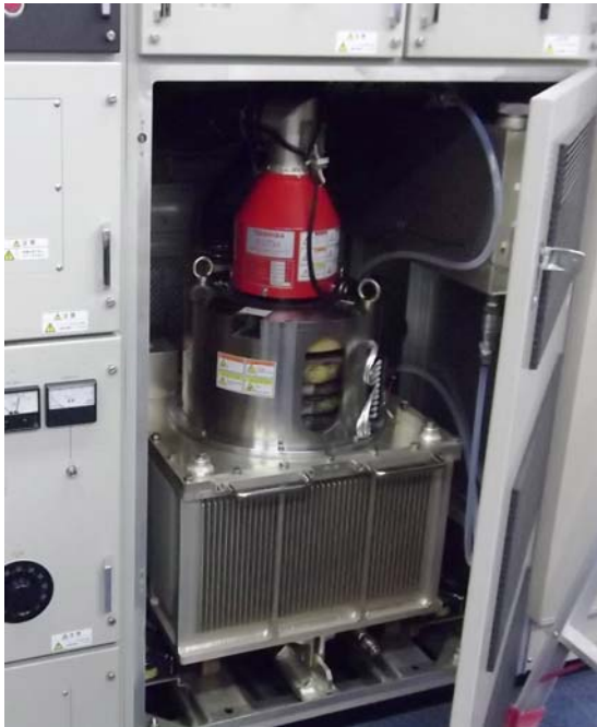
前装置送信機クライストロン（真空管）
