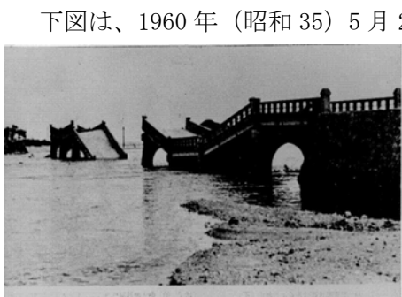
[津波により破壊された屋我地大橋] (沖縄タイムス提供)
