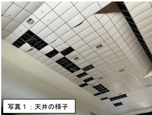
写真1、2 体育館の天井パネル（断熱材）の落下（砂美地来館：与論町茶花）
