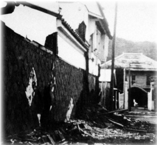
破損した外壁(都留市内)
