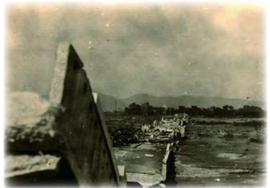
酒匂川国道の橋(神奈川県)
