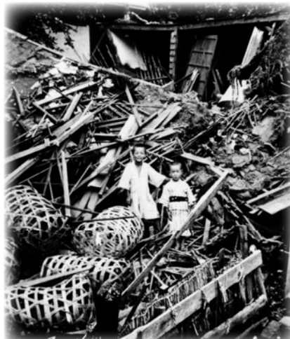
倒壊した家屋(都留市内)
