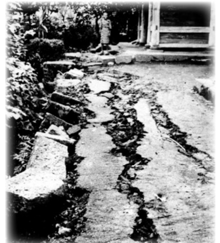
円通院山門付近の地割れ(都留市内)
