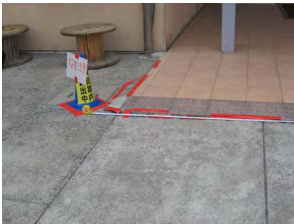
写真4 宮代町庁舎東側の地面陥没（幅 5.6m 陥没深さ 0.02m）（南埼玉郡宮代町笠原）
