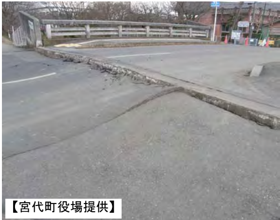
写真3 橋梁接続部の道路陥没及び亀裂（南埼玉郡宮代町百間）
