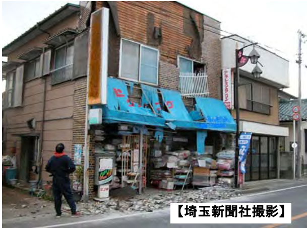
写真5 商店外壁タイルの崩落 (幸手市中)
