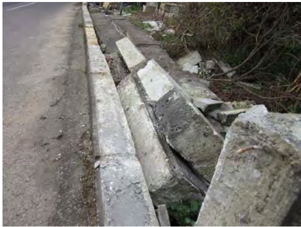
写真2 ブロック塀の破損（南埼玉郡宮代町東条原）
