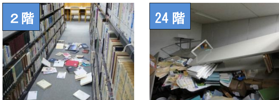
図2 同じビルの高階層と低階層での被害の違い（工学院大学提供）
