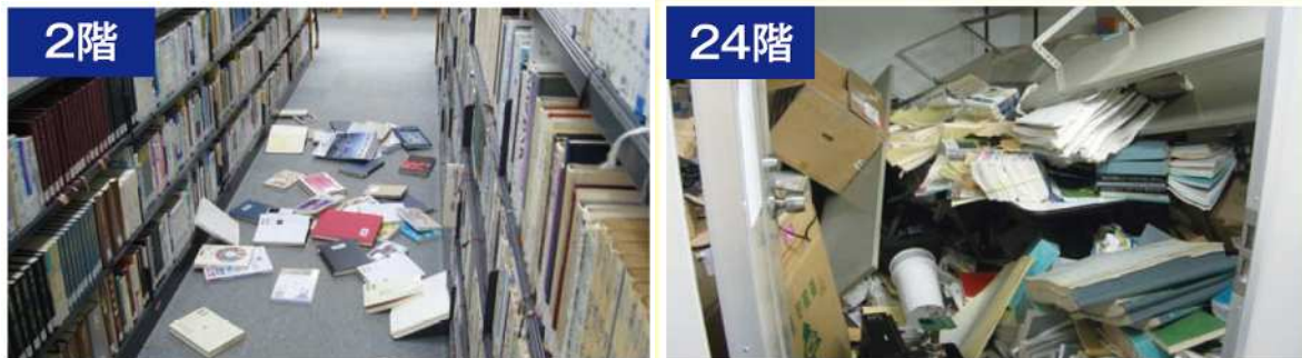
写真 東京都内の同一ビルにおける低層階(2階)と高層階(24階)の被害状況
