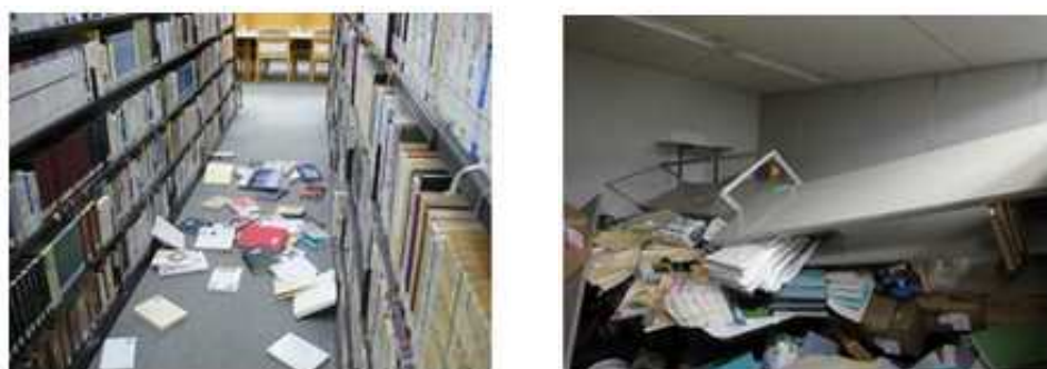
図 3 東京都内の同一ビルにおける低層階と高層階の被害状況（左：低層階 2 階 右：高層階 24 階）
