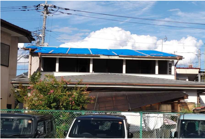
① 屋根ふき材がはく離した住家 (南西方向から撮影)
