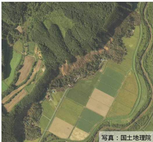
平成 30 年北海道胆振東部地震 地震発生後
