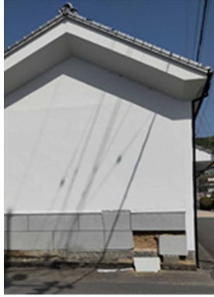
図4 土壁の破損（宇和島市吉田町）
