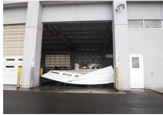
②破損した鉄骨造倉庫のシャッター (上部が折れ曲がり、レールから外れて落ちた)
