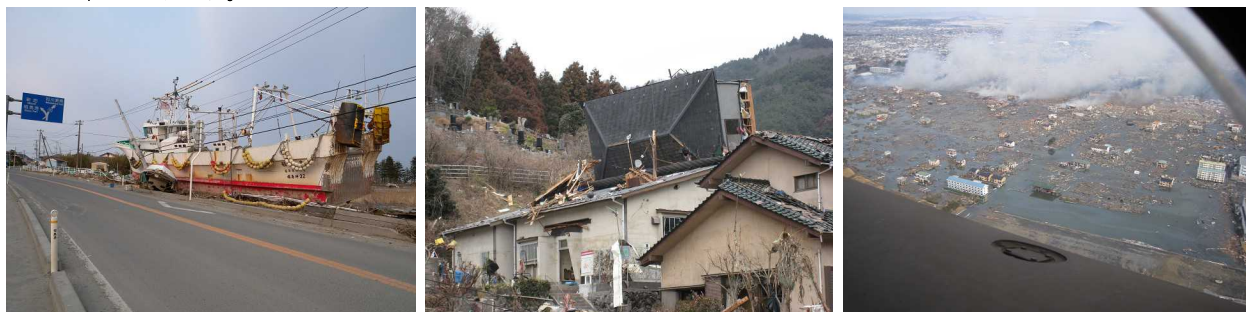
東日本大震災の被害の一部（左が福島県相馬市、中央が宮城県女川町、右が宮城県石巻市）
