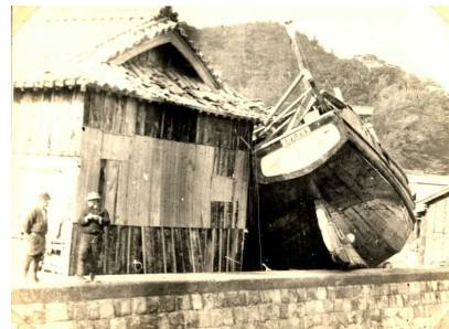
1946年昭和南海地震の被害の様子 徳島地方気象台ホームページより （徳島県由岐町、現在の美波町）
