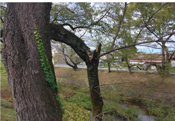
⑤ 枝が折れた樹木 (南東方向から撮影)
