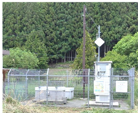
天川村に設置している地震計
