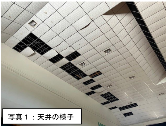
写真1、2 体育館の天井パネル（断熱材）の落下（砂美地来館：与論町茶花） （写真提供：与論町）
