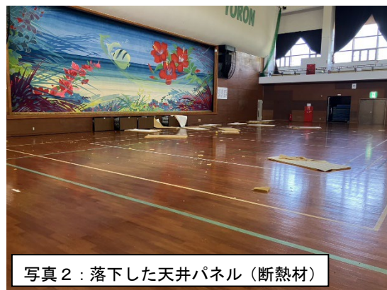
写真1、2 体育館の天井パネル（断熱材）の落下（砂美地来館：与論町茶花） （写真提供：与論町）
