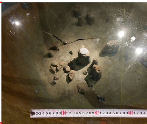
写真② 床のガラスの破損 (浦幌町立博物館：浦幌町桜町)
