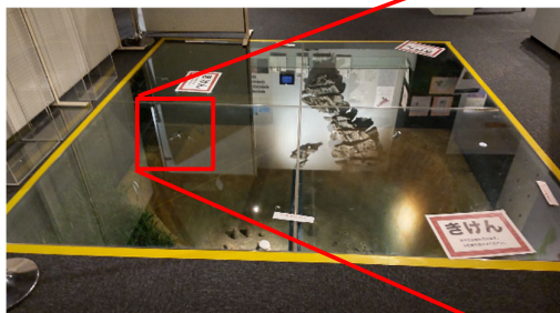
写真① 床のガラスの破損 (浦幌町立博物館：浦幌町桜町)
