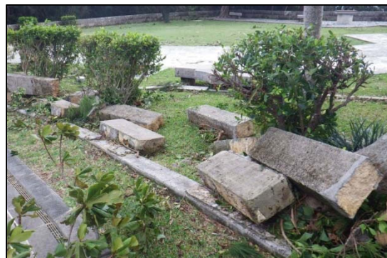
⑦ 石塀の倒壊
