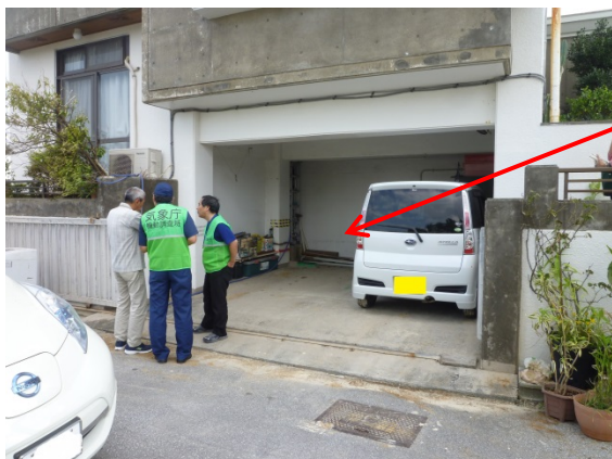
写真 3 : 民家浸水痕跡
