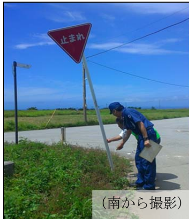
① 道路交通標識の傾倒
