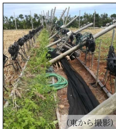
⑦ 木製柱の折損・傾倒 (北に倒伏)
