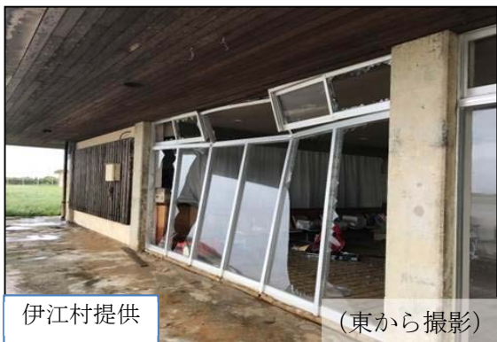
④ 空港管理事務所の窓ガラス破損
