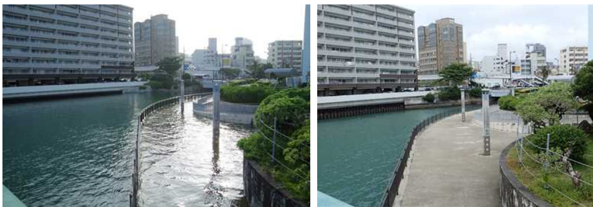
水没した遊歩道 平常時の遊歩道 第3図 平成26年8月12日の異常潮位と大潮による冠水害（那覇市）
