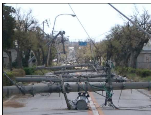
暴風により倒壊した電柱(気象台職員撮影)
