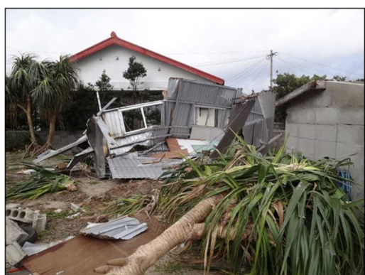
建物の倒壊【与那国島】(気象台撮影)
