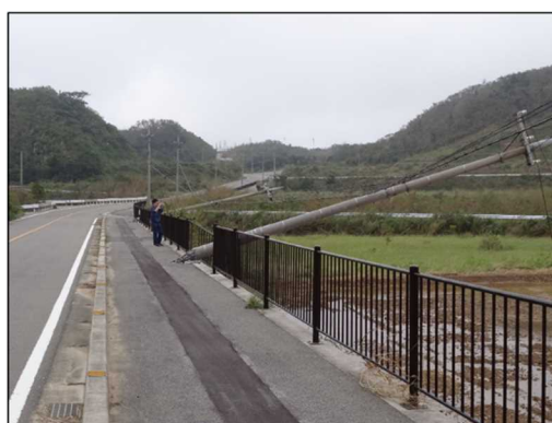
電柱の倒壊【与那国島】(気象台撮影)
