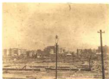
東京駅前の焼け跡、日本橋方面
