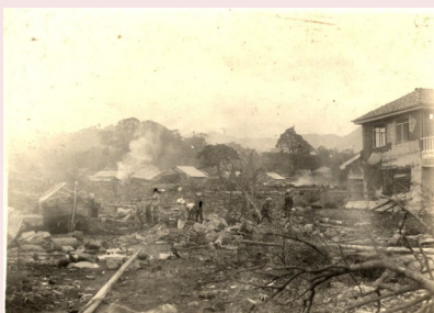
伊東海岸津波の跡
