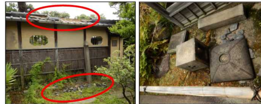
写真は吹田市内本町(左:瓦の落下 右:石灯籠の転倒) 平成30年災害時地震報告(気象庁)
