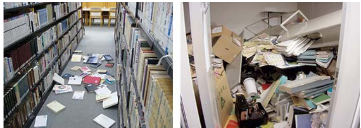
写真 同じ高層建築物の2階（左）と24階（右）の被害状況（内閣府HPから引用）
