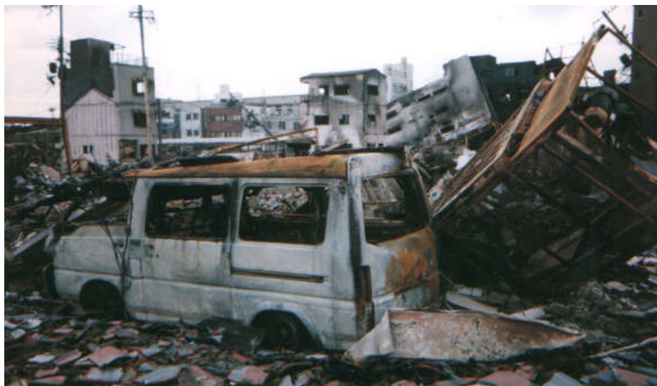
阪神・淡路大震災で 焼失した地域 (神戸市須磨区寺田町)
