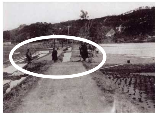
図7-7 北丹後地震による道路の食い違い [海洋気象台撮影]
