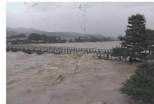
提供：国土交通省近畿地方整備局 桂川渡月橋(京都市右京区)
