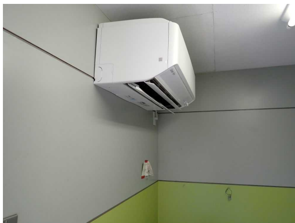
写真 2. 既存室内機②
