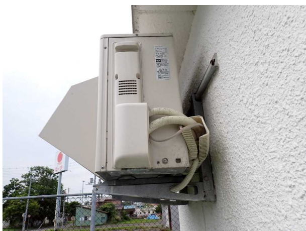
写真 5. 既存室外機②
