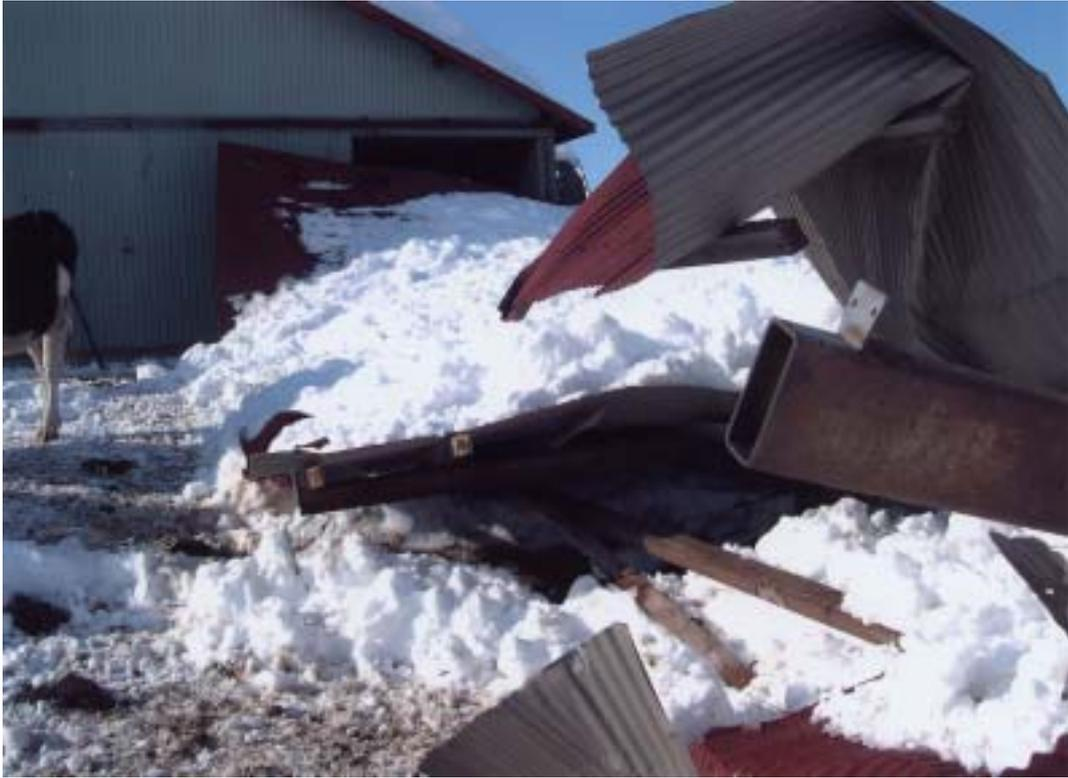
大雪のため倒壊した乳牛の飼料給餌舎(1月16日中川郡豊頃町:日本農業新聞提供)
