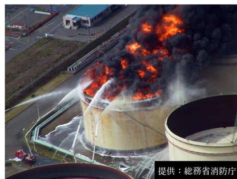
図3 大型タンク類の被害
