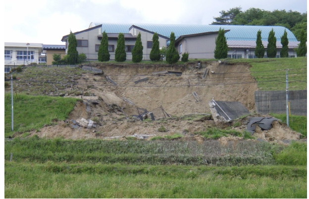
写真2. 栗原市鶯沢の法面崩落
