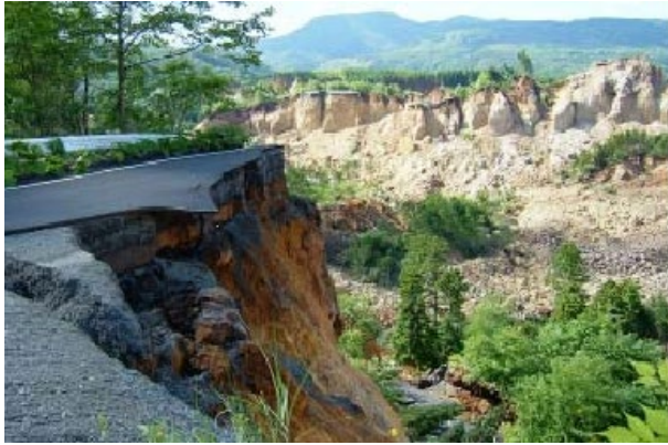
写真1. 荒砥沢ダム周辺の大規模崩壊（栗原市提供）
