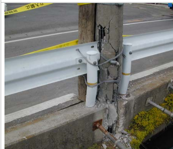
写真3 電柱の破損
